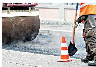
**9.** L'additivo Cecabase RT® fluidifica il bitume stradale durante la posa. In questo modo la temperatura di riscaldamento si abbassa, in modo da consumare meno energia, nell'ordine del:
