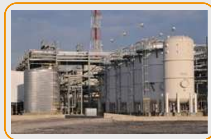
Saint-Charles site, USA
